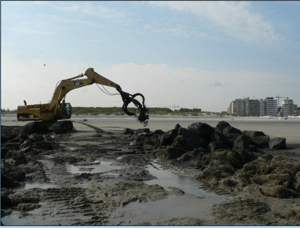
Figuur 11: Foto van de ruimingswerken van strandhoofd 51.
