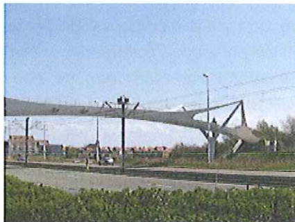
Foto 5: Nieuwe fiets- en voetgangersbrug te Heist (Lichtenlijn)
