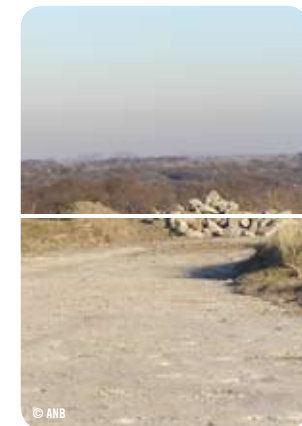
In het zwin worden oude betonpaden opengebroken en nieuwe wandel-, fiets- en ruiterpaden aangelegd.
