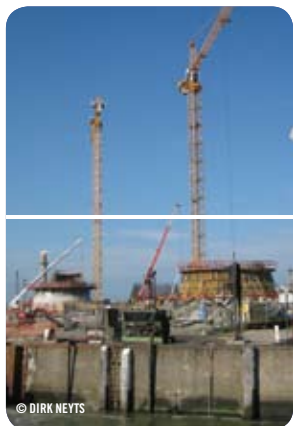
De 6 betonnen sokkels, die de windturbines ondersteunen werden 30 km in zee naar de Thorntonbank getransporteerd.
