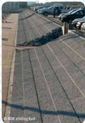
Een opmerkelijke realisatie is de constructie van een stormmuur in de vorm van een golfbreker in Blankenberge.
